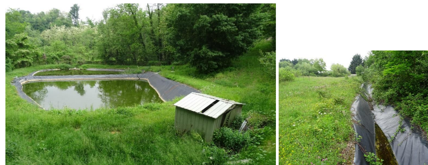
Photographie 5. Bassins de traitement des eaux (lixiviats et eaux pluviales) et fossé étanché ceinturant le sud et l'ouest de la décharge – Eco-Stratégie, 18/05/2018
