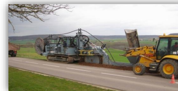
Photographie 4 - Réalisation d'une tranchée (Source : URBASOLAR)
