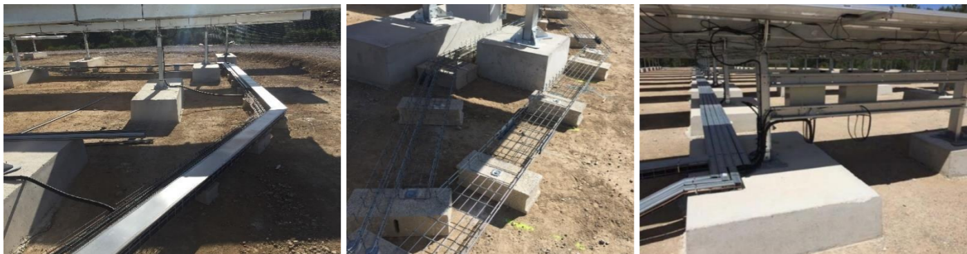
Photographie 2. Passage de réseaux en aérien sur longrines (chantiers Urbasolar)
